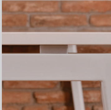
DETAIL ULOŽENÍ STOLOVÉ DESKY NA KOVOVÉ PODNOŽI
